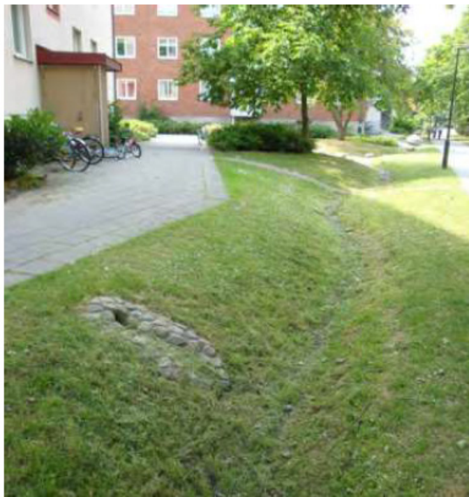
Figur 13: Exempel på Svackdike. Källa: RG dagvattenhandbok.
